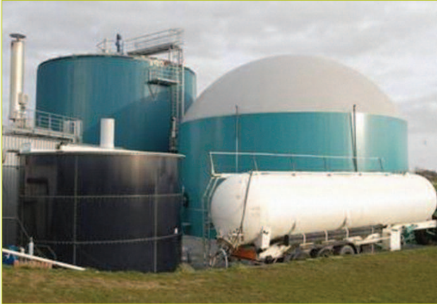
Exemple d'usine de biométhanisation
